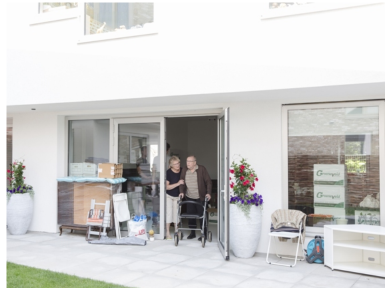
De overhellende betonplaat: goed tegen direct zonlicht en voor de privacy.
