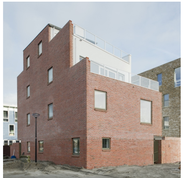
De bakstenen buitenmuren: bescherming tegen de buitenwereld.
