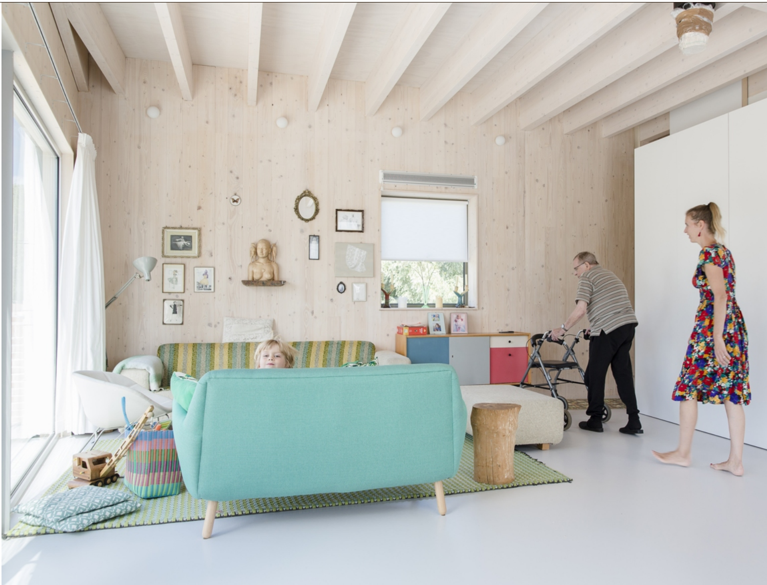
In de leefruimte bij het jonge gezin boven: de houten muren hebben een vochtregulerende werking.
